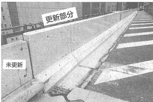
高速道路の改良工事では、壁高欄の厚さをあまり大きくすることができないため、薄い壁厚で必要な衝突安全性を確保するための検討も行いました。
